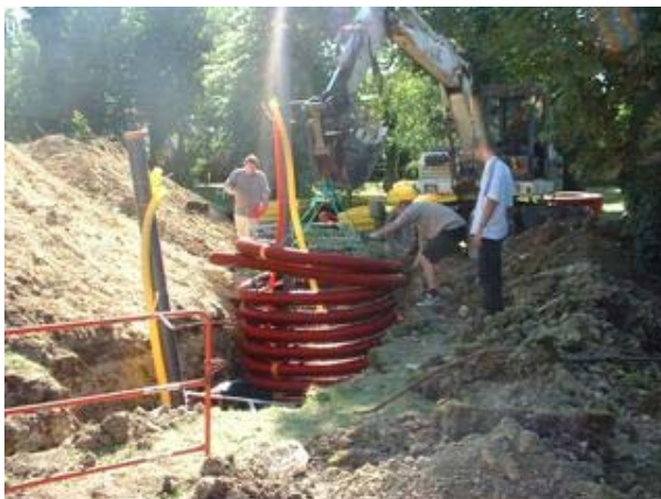
Réseau de puits canadiens en cours de réalisation
